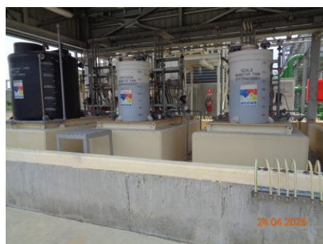
ภาพที่ 2.2-57 คันคอนกรีตบริเวณพื้นที่จัดเก็บสารเคมี
