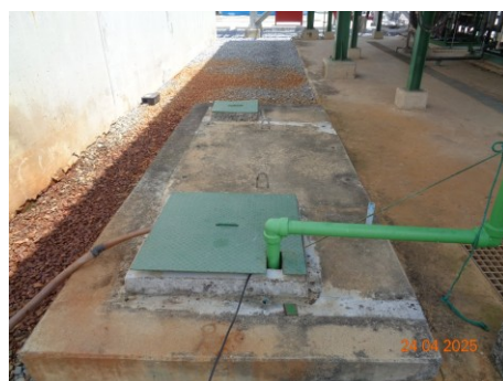
ภาพที่ 2.2-13 บ่อพักน้ำทิ้ง (Sump Pit)
