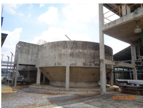
ภาพที่ 2.2-14 บ่อรวบรวมน้ำทิ้ง (Retention Tank)
