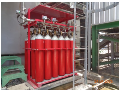
ภาพที่ 2.2-48 ระบบดับเพลิงแบบใช้ก๊าซคาร์บอนไดออกไซด์ CO2 บริเวณ Gas Turbine
