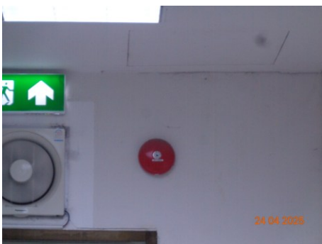
ภาพที่ 2.2-36 ระบบตรวจสอบ ตรวจจับ และสัญญาณเตือนภัยแบบอัตโนมัติ บริเวณพื้นที่โครงการ
