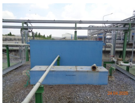
ภาพที่ 2.2-15 ถังแยกน้ำ-น้ำมัน (Oil Separator)
