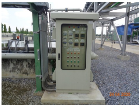
ภาพที่ 2.2-18 ระบบตรวจวัดคุณภาพน้ำจากท่อหล่อเย็น แบบต่อเนื่อง
